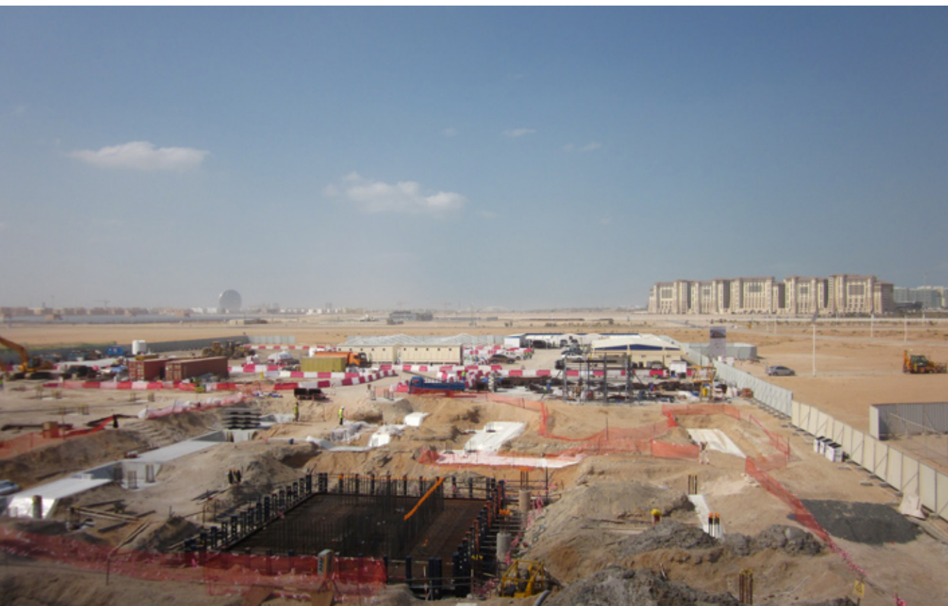
从马斯达城市的施工现场不难看出,这片土地的本来面貌:干燥、缺水、日光充足
